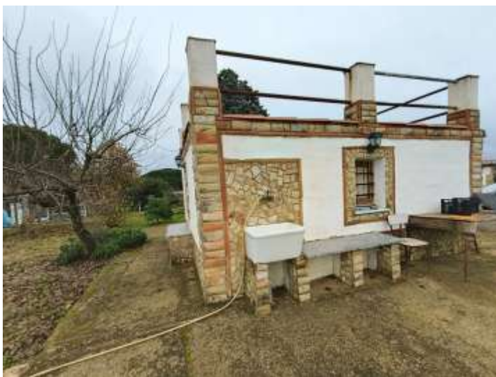
FOTO N. 17 PROSPETTO OVEST GARAGE
