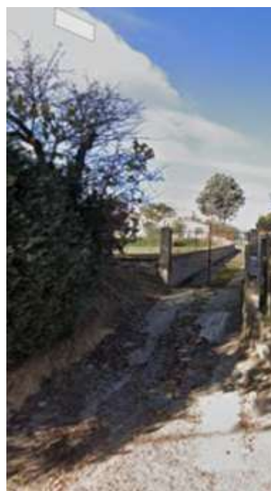
FOTO N. 3 INGRESSO- STRADELLA PRIVATA REALIZZATA PARTE SULLA PART.LLA N. 178
