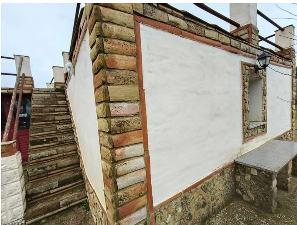
FOTO N. 15 PROSPETTO NORD GARAGE
